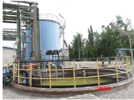
ภาพที่ 2.2-7 ถังปรับสภาพน้ำให้เป็นกลาง
